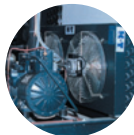
Anlage örtlich montiert
