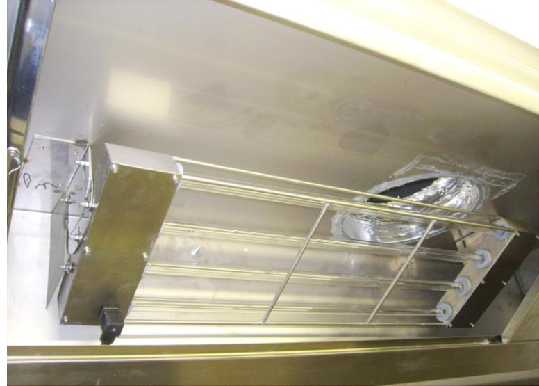
UV-C-Modul AerO<sup>3</sup>4-40 mit 360°-Rundumbestrahlung
